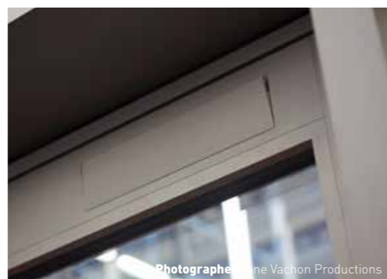
Trappe d'accès pour maintenance
