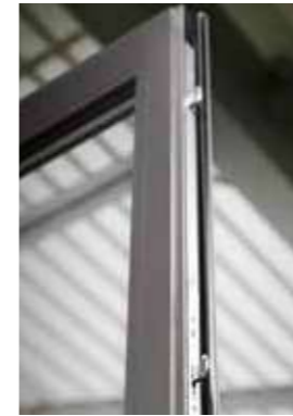
Points de verrouillage avec tête inox
